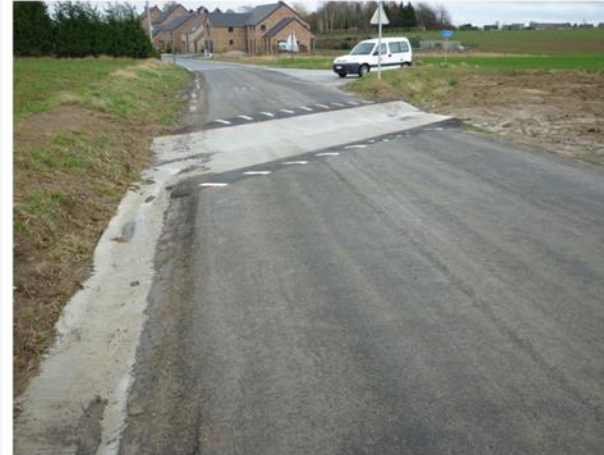
Passage d'eau - cassis
