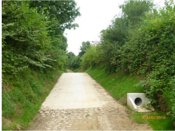
Stockage sur voirie
